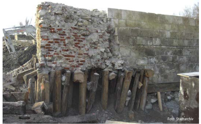
Hölzerne Fundamente trugen die Ingolstädter Festungs- und Industriebauten am Nordufer der Donau. Im Mittelalter kam das Bauholz zunächst aus den Donauauen und der näheren Umgebung, später von weit her bis aus den Hochalpen.
